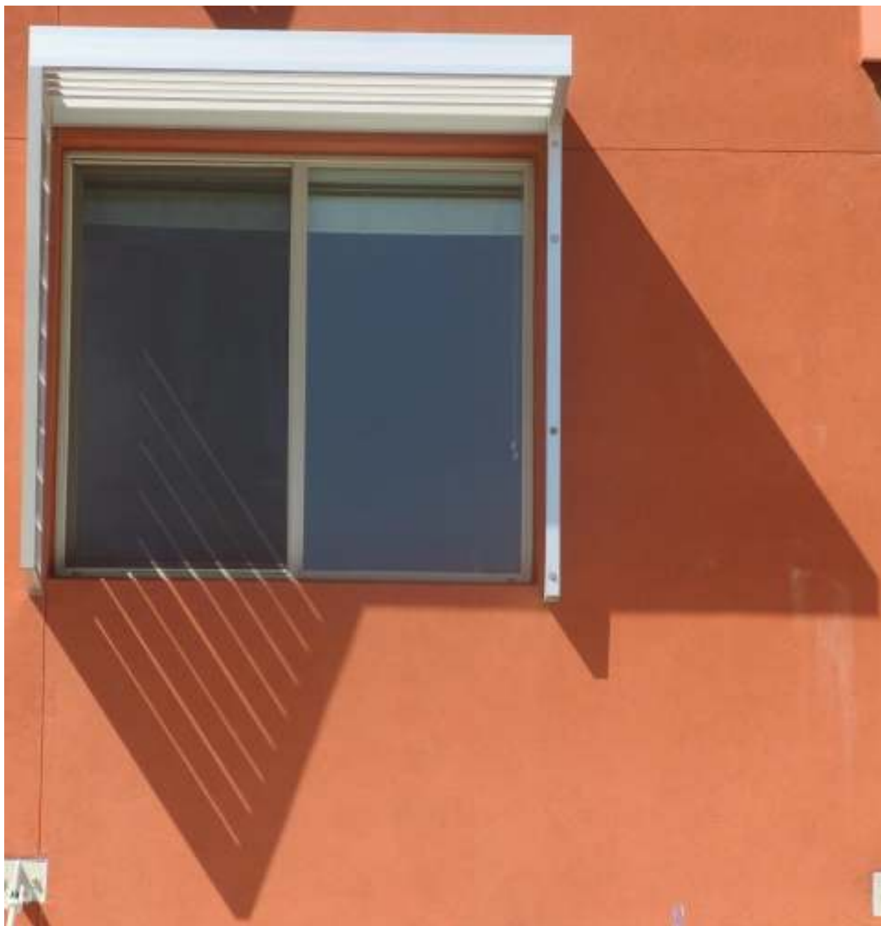
Ventana con sombreado en edificio de departamentos en campus de UC Davis, California
