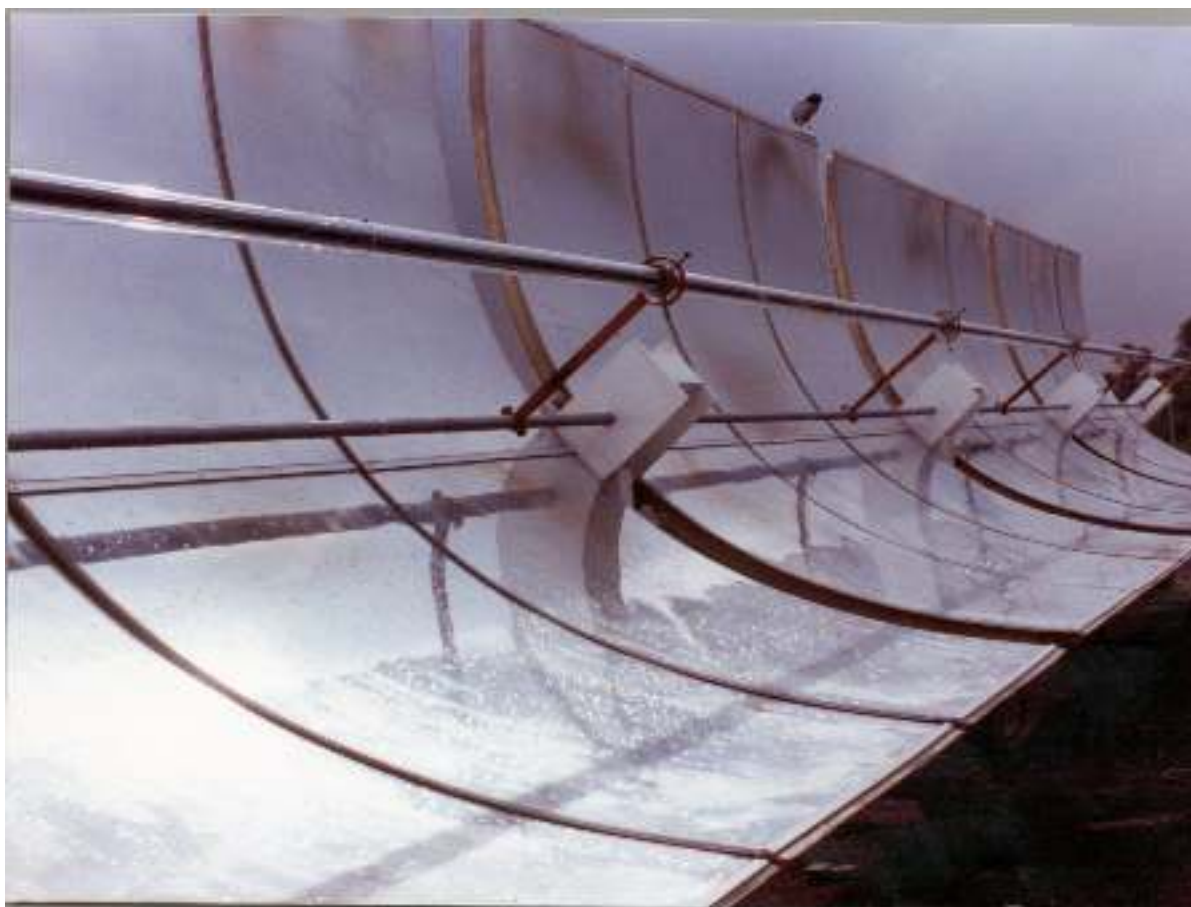
Colectores cilíndrico-parabólicos de la planta solar instalada junto al Jardín Botánico de Ciudad Universitaria en CDMX. Foto tomada en 1984
