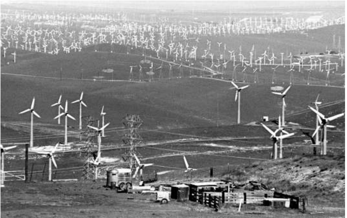
Aerogeneradores de primera generación en Altmont Pass, California, 1989
