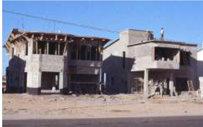
Foto: casa en construcción en BCS
