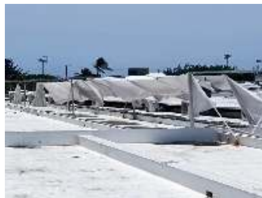
FOTOGRAFÍA 8. REHABILITACIÓN DEL ÁREA DE SECADO SOLAR EN LA AZOTEA DEL MOTEL.
