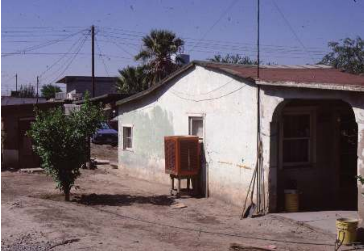
Enfriador evaporativo en vivienda en Mexicali, 1984
