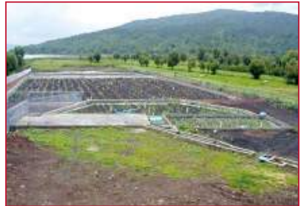
Ilustración 3.3 Humedal artificial de flujo subsuperficial subterráneo
