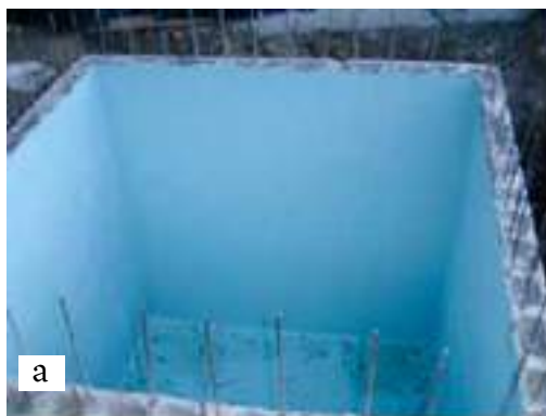
Ilustración 3.8 Diferentes materiales constructivos para reactores de biofiltración sobre material orgánico a) concreto armado; b) castillos dalas y tabiques y c) ferrocemento
